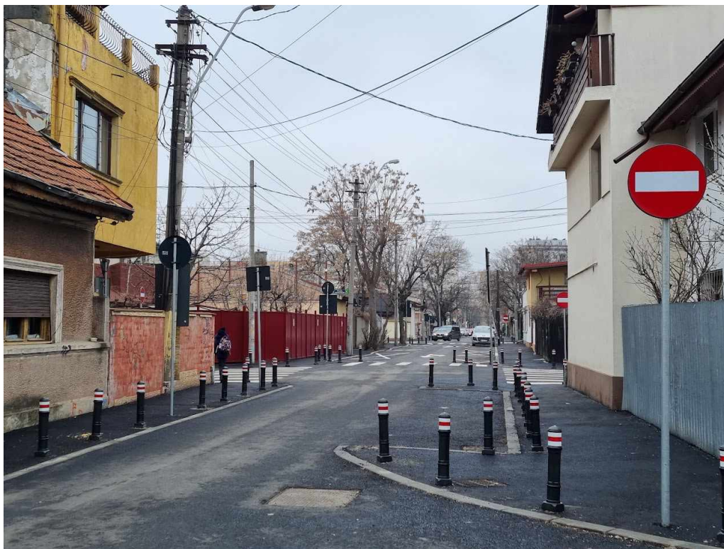
Fig. 9.4.9. Dispozitive de protecție pentru pietoni montate pe trotuar (sursa: https://www.hotnews.ro/stiri-administratie_locala-26550713-cat-platesc-primariile-din-bucuresti-pentru-stalpii-care-pun-impiedice-parcarea-trotuar.htm )
