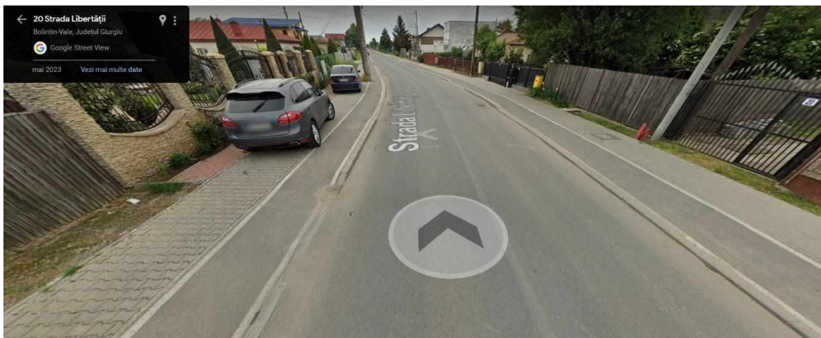
Fig. 2.2.8 Exemplu de stradă de categoria III – colectoare din orașul Bolintin Vale (Strada Libertății) (Sursa: Google Street View)
